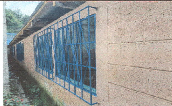
Foto 4: Mnatenimiento de balcones
