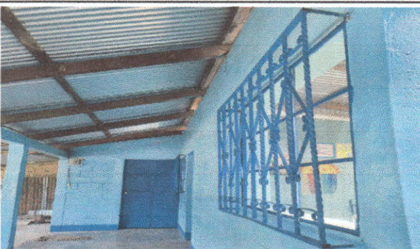
Foto 6: Mantenimiento de puertas
