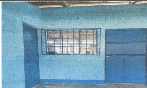
Foto 3: Mantenimiento de balcones
